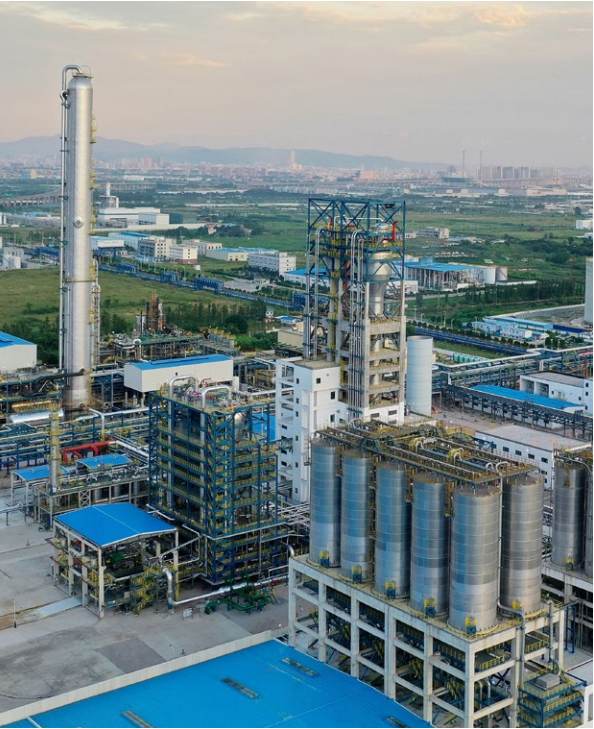
▲ 广物控股集团丙烷脱氢制聚丙烯项目一期年产60万吨工程建成投产
